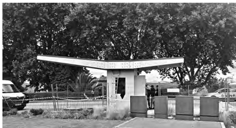
INFRAESTRUTURA VISA FACILITAR MOBILIDADE URBANA
