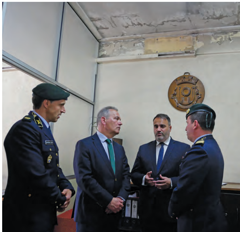
SECRETÁRIO DE ESTADO VERIFICOU CONDIÇÕES PRECÁRIAS DO QUARTEL
