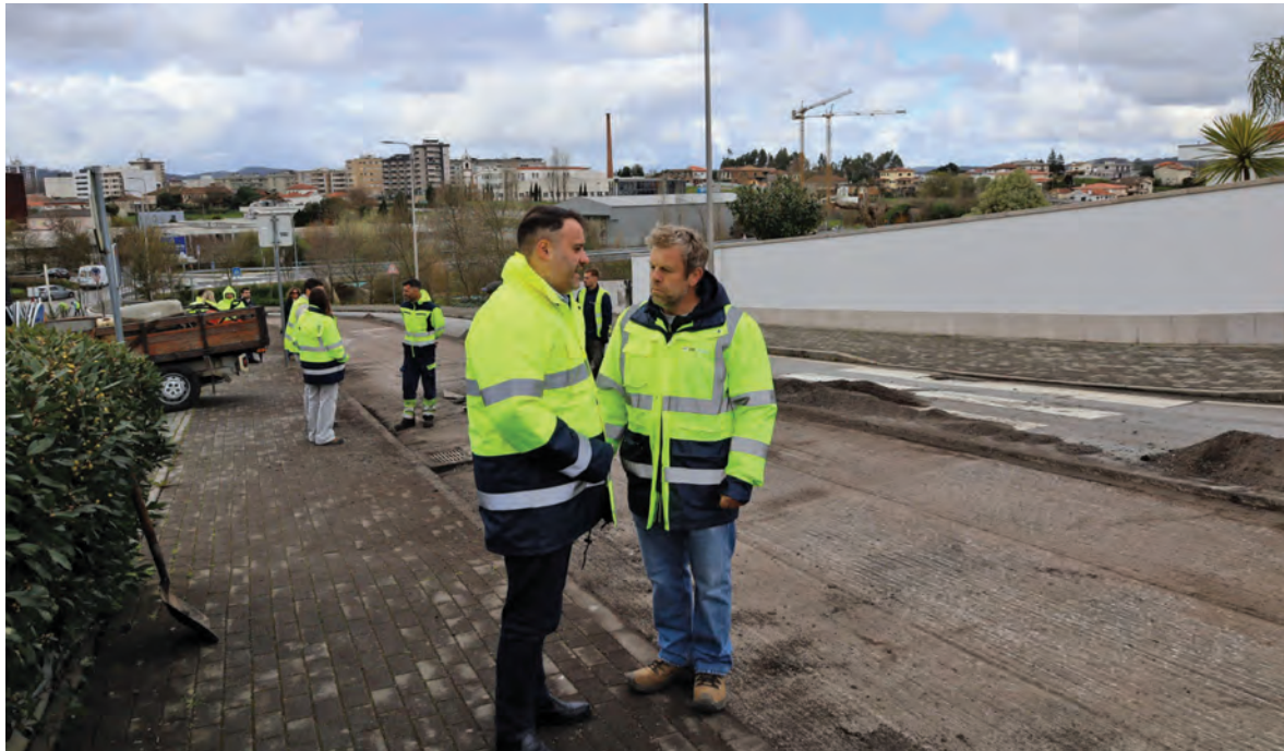
OBRA SERÁ REALIZADA EM QUATRO ETAPAS
