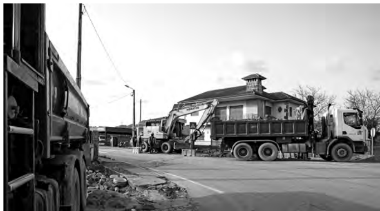
IP IRÁ CONSTRUIR MAIS DE 4700 METROS DE NOVOS PASSEIOS
