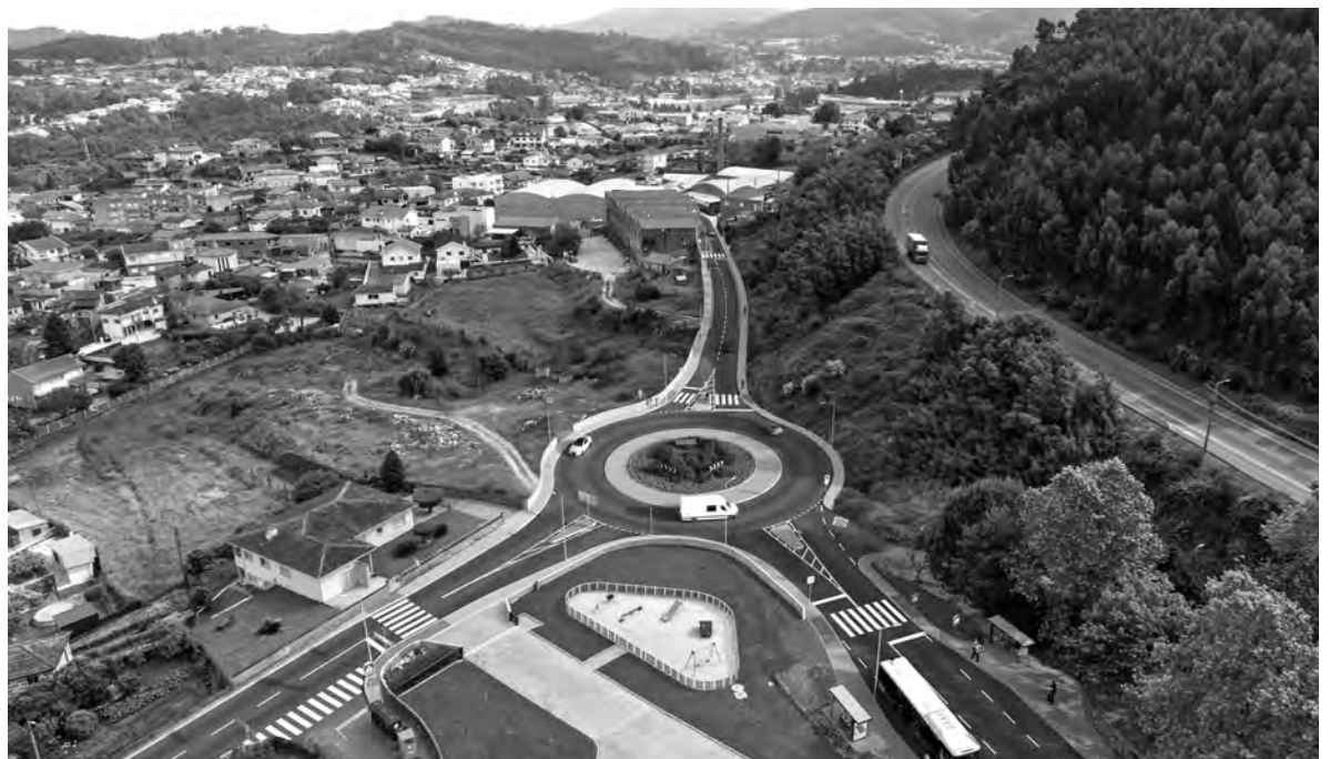
OBRA CONTEMPLA CONSTRUÇÃO DE UMA ROTUNDA NA RUA DAS LAGINHAS
