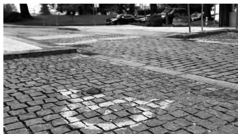
SENSORES PERMITEM MONITORIZAR A OCUPAÇÃO DAS VAGAS
