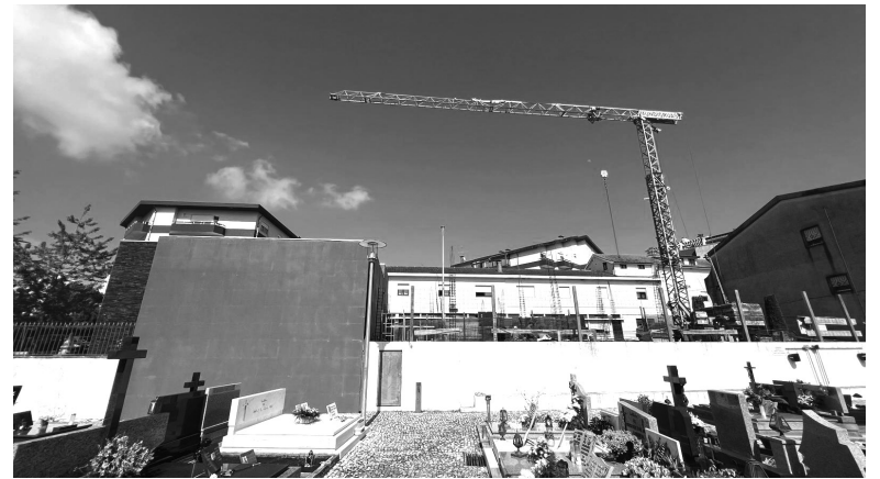
CASA MORTUÁRIA ESTÁ A SOFRER OBRAS DE AMPLIAÇÃO
