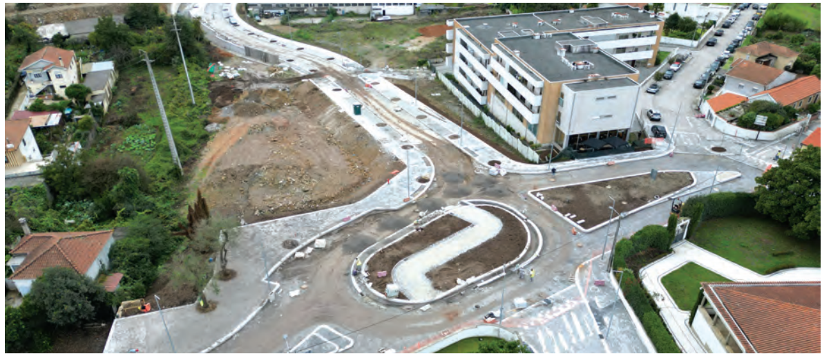
“CONTRATEMPOS” ATRASARAM A OBRA
