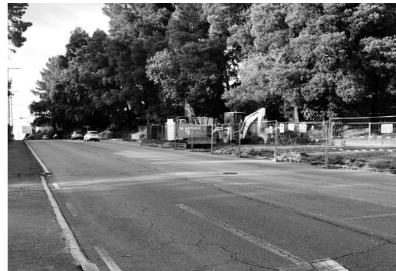
CONCLUSÃO DA OBRA PREVISTA PARA ABRIL DE 2025
