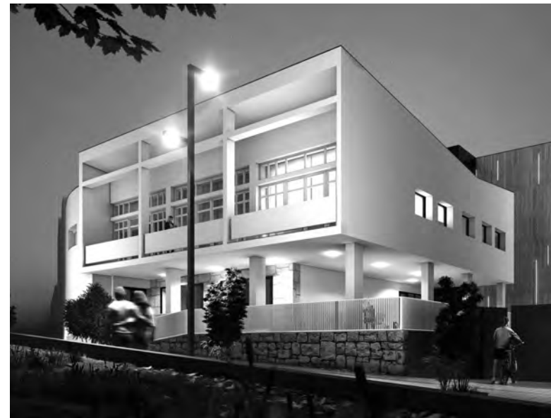
PRR FINANCIA OBRAS NA RESIDÊNCIA DE ESTUDANTES
