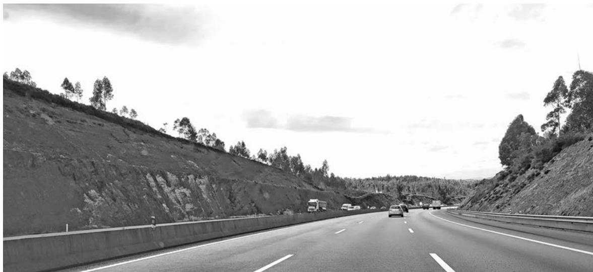
PRIMEIRO PONTO DO RADAR ESTÁ COLOCADO NO KM 16,910 E O SEGUNDO NO KM 15,905, NO SENTIDO BRAGA-PORTO
