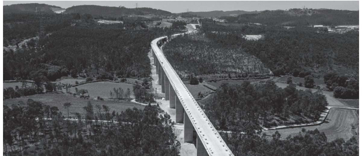
OBRA DECORRE A BOM RITMO
