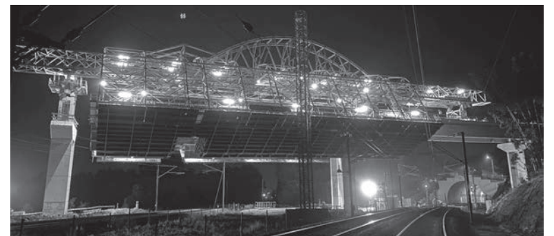
VIADUTOS E PONTES CONSTRUÍDAS COM RECURSO A TECNOLOGIA DE PONTA
